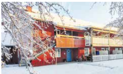
Vi installerar portkoder i kvarteret Ålen 1.
