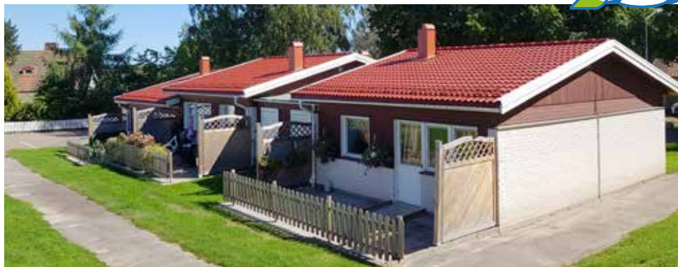
Bild från sommarens takbyte på Hemgatan-Slöjdgatan.
